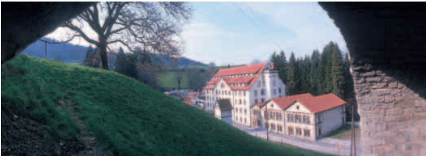
Brückenschlag: Unter der Weissenbachtobelbrücke im Neuthal steht das Spinnerei-Ensemble, darüber fährt die DVZO.
